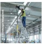
Bei Höhenarbeiten bieten Stufen- und Podestleitern einen sicheren Stand.
